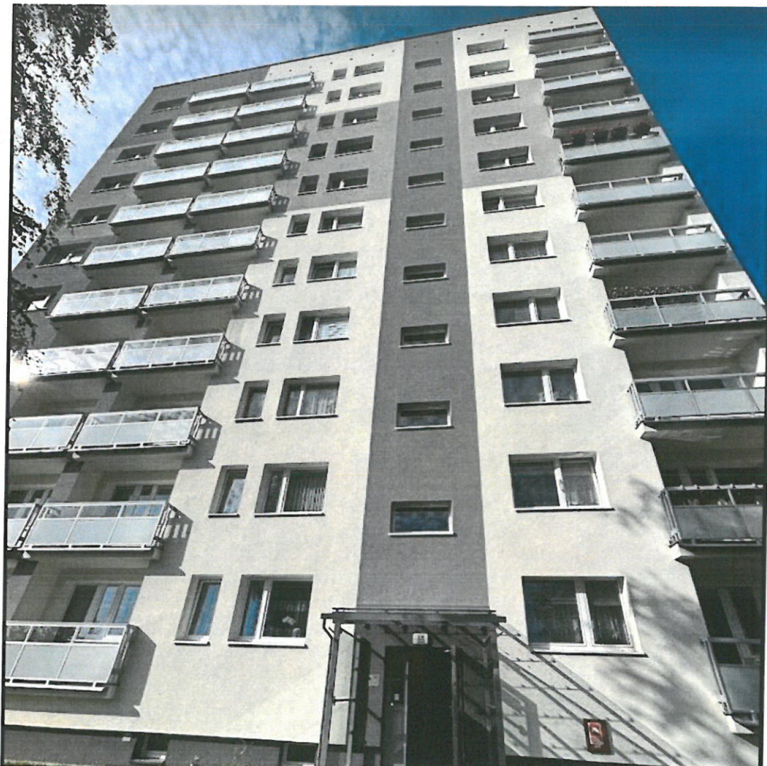
Fot.1. Budynek przy ul. Słonecznej 65.
