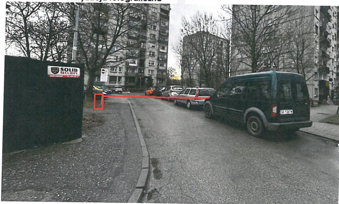
Fot.1. Planowane posadowienie szlabanu przy ul. Słonecznej 78.
